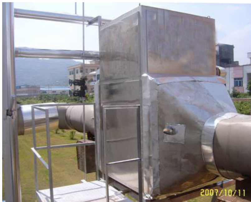
锅炉烟气余热回收节能改造
