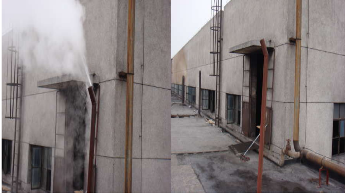
改造前，除氧器排气口排出大量蒸气。 改造后，除氧器乏气全部回收利用，排气口不再排气。
