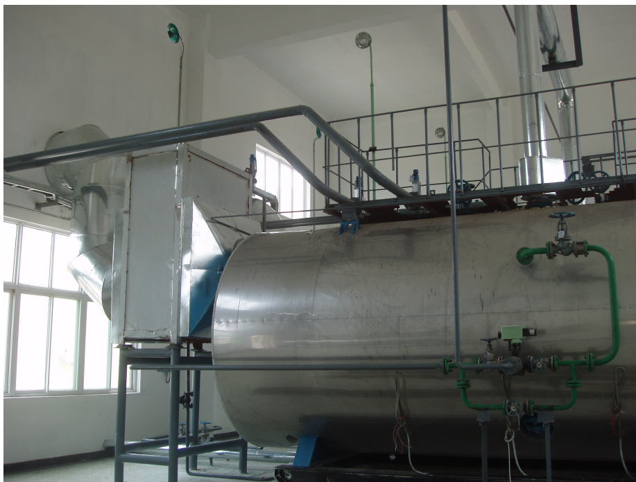
锅炉烟气余热回收节能改造
